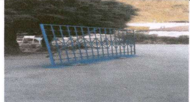
Foto 4: Fabricación e instalación de balcones de hierro en ventana
