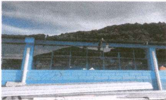
Foto 3: Sustitución de canal de metal
