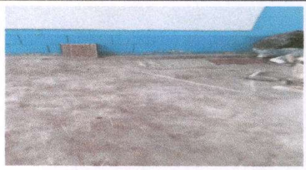
Foto 2: Sustitución de piso de cemento líquido Por piso ceramico
