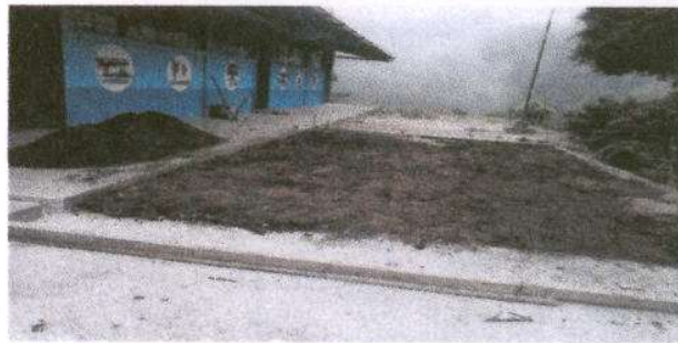
Foto 6: Sustitución de piso de torta de concreto
