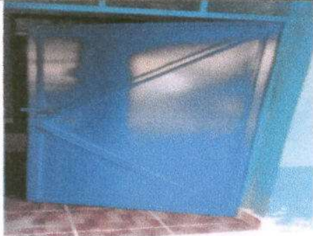
Foto 1: Mantenimiento a estructura (lijado, cambio de tubo, cepillado, sujeciones, aplicación de pintura)
