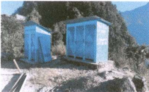
Foto 5: Fabricación e instalación de puertas de metal en baños
